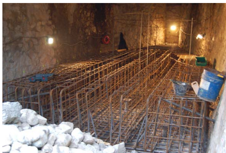
Ferrailage de la dalle d'assise de la tome
