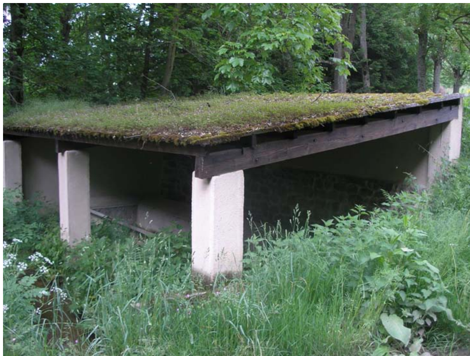
Lavoir du Crouzet – Avant Travaux
