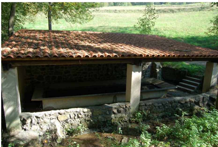
Lavoir du Crouzet – Après Travaux
