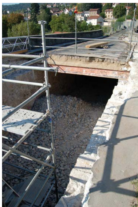
Ouverture de la chambre de la culée en rive gauche
