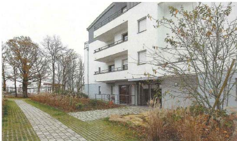
Traitement d'allées perméables à Chantepie (35)
