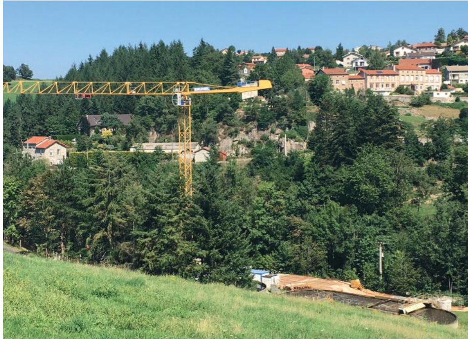
Station d'épuration Saint-Didier / La-Séauve
