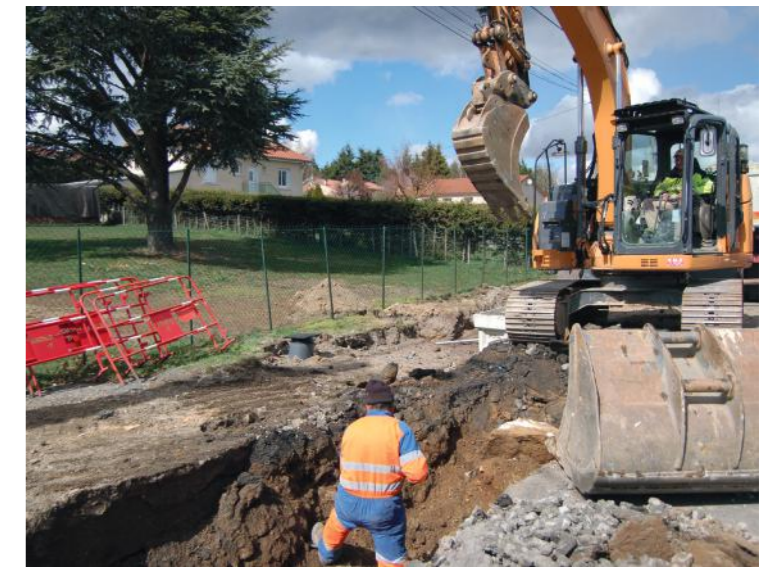
Travaux sur la RD500 à Saint-Didier-en-Velay - Avril 2019
