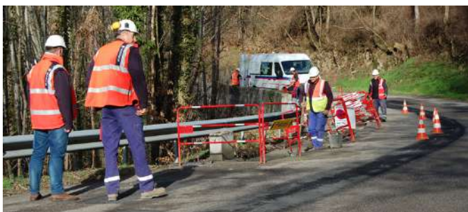
Travaux de voirie
