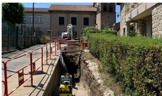
Travaux Boulevard des Jardins - Saint-Didier-en-Velay
