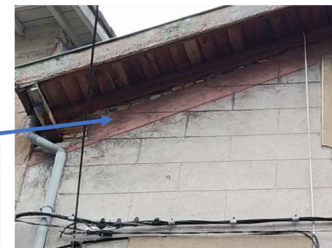
Bandeau en trompe l'œil sous forget, badigeon filet d'ombre
