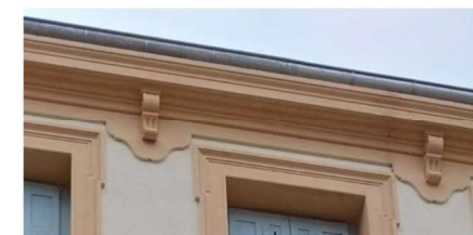
Corniche en ciment prompt naturel
