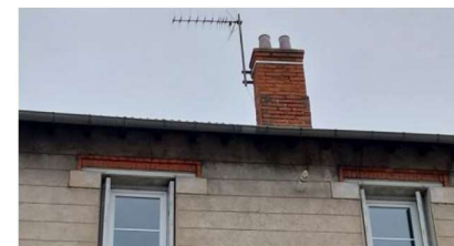
Cheminée en brique
