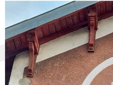
Forget saillant avec corbeau en bois
