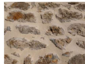
✓ Joints à la chaux « à pierres vues »
