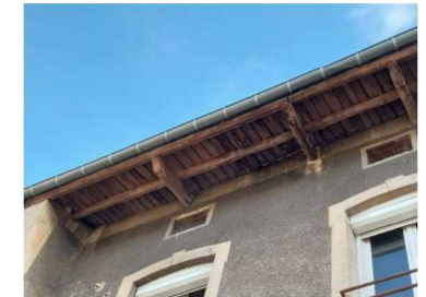
Forget avec chevrons apparents
