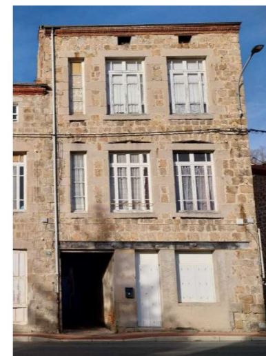
✓ Grands moellons formant une assise horizontale régulière, joints larges à fleur de pierre, encadrement en pierre de taille
