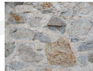
✓ Enduit à pierres vues
