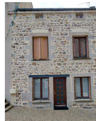
Petits moellons sans appareillage, encadrement en pierre de taille, enduit à pierres vues
